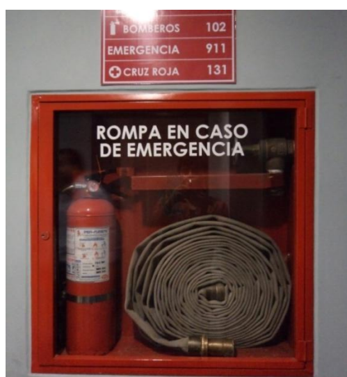
Foto 4. Caja BIE existente en el piso donde esta ubicada la SENPLADES Zona
