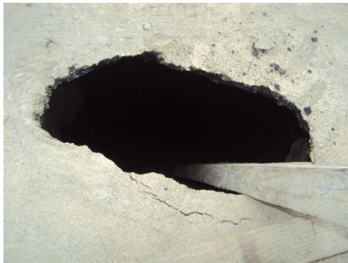
Fotos : 7 y 8 de hundimiento en la calle principal del barrio
