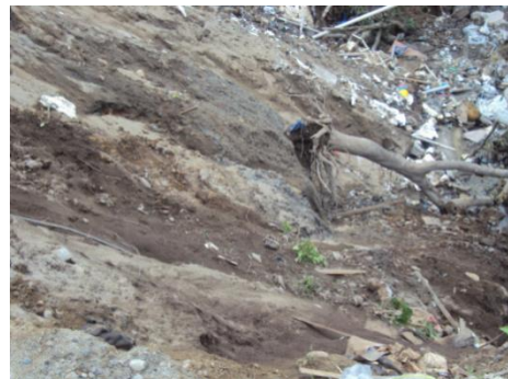
foto 6: botadero de basura en deslizamiento
