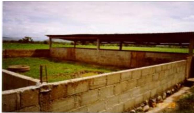
Para la cubierta se recomienda el uso de planchas de zinc, eternit, también el uso de traslúcidos, ayuda al paso de luz hacia el interior de las instalaciones, permitiendo que la temperatura aumente al interior y propiciando un mejor confort para los animales. En lo referente a la estructura de la cubierta, se recomienda que la misma tenga dos caídas, para ayudar a la fluidez del agua cuando existan precipitaciones.
