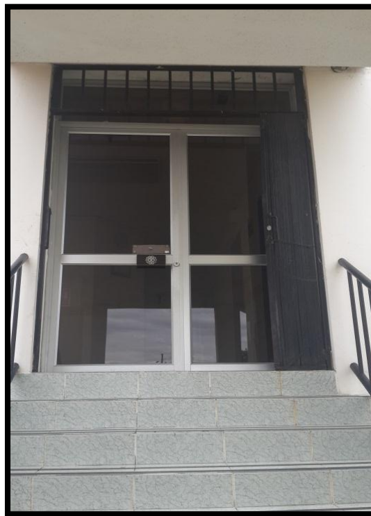
Ingreso a la Dirección Distrital Distrito 05D06 – Salcedo
