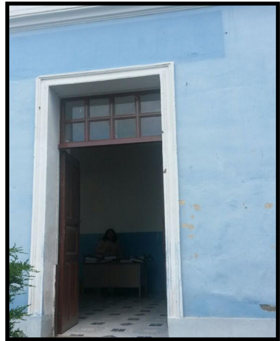
Ingreso a la Dirección Distrital 06D02 Alausí – Chunchi.
