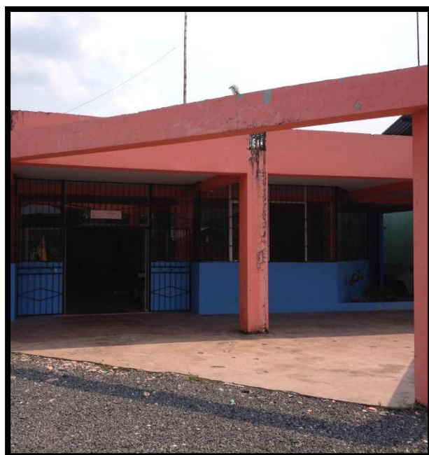
Ingreso a la Dirección Distrital Distrito 16D02 Arajuno
