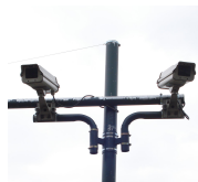
Fotografía # 20 . Pórtico de Telepeaje
