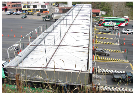
Fotografía # 3 . Cubierta de la Estación de Peaje
