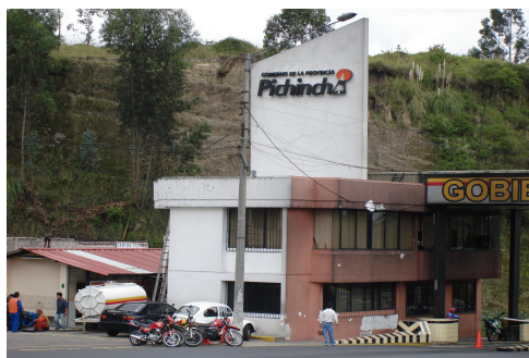
Fotografía # 6. Edificio Administrativo
