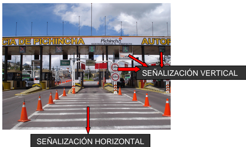
Fotografía # 14 . Detalle de la Señalización
