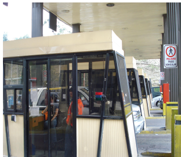
Fotografía # 9 . Cabina de Cobro
