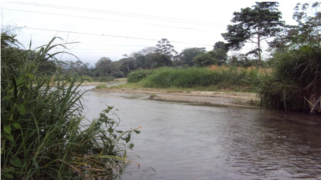
Foto 2. Diques de tierra levantados en las orillas del río y depósito de sedimentos
