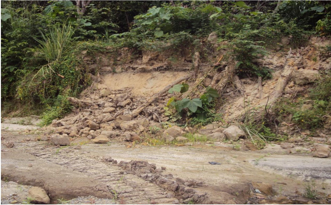
Foto 7. El ingreso de maquinaria al lecho del río altera la estabilidad de las orillas
