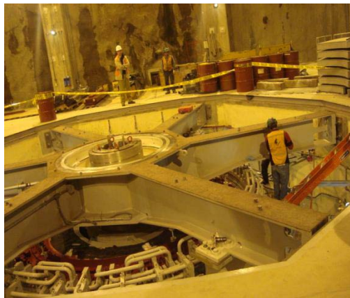
Montaje de cruceta superior del generador 2
