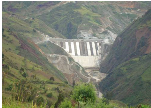
Vista de la pared frontal de la Presa
