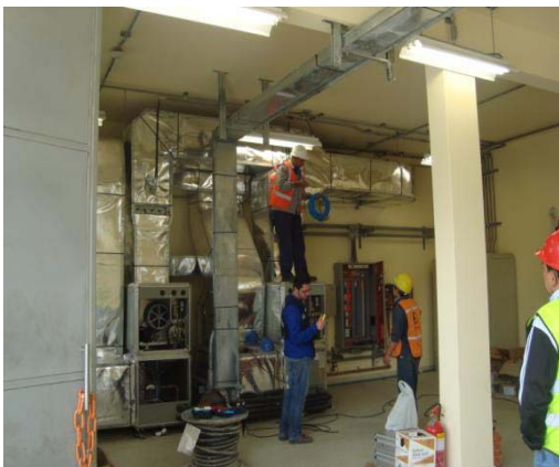
Montaje de equipos de aire acondicionado
