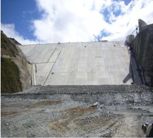
Hormigón terminado de la cara impermeable de aguas
