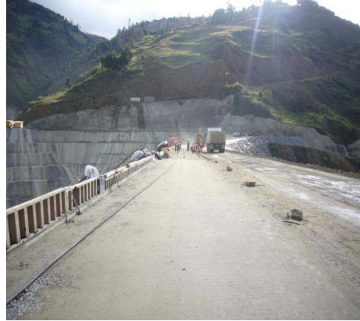
Cresta de la presa: preparación de trabajos
