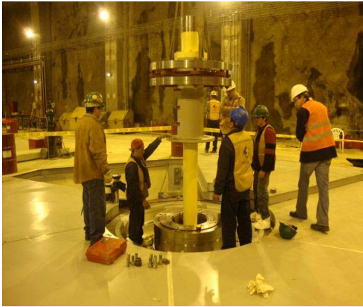
Montaje del anillo colector
