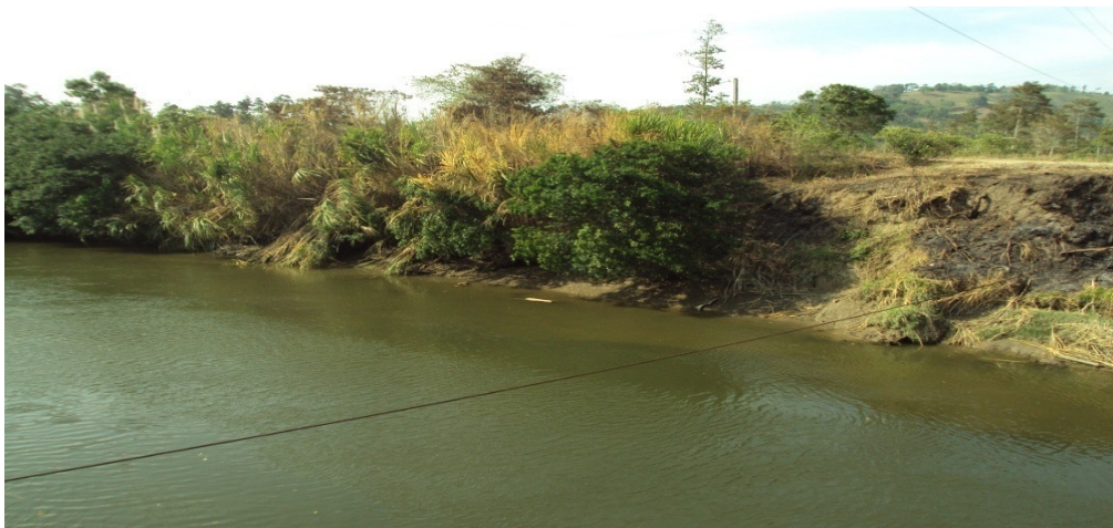
Foto 4.- Escalinata 3, al otro lado del río (Proyecto construcción escalinata no. 2) Comunidad San Vicente - 12 de octubre del 2010
