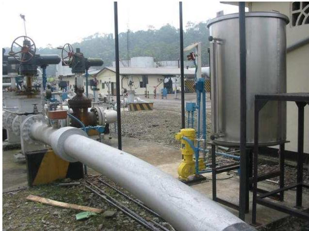
Gráfico No. 8: Bomba dosificadora (color amarillo) de químico inhibidor de corrosión
