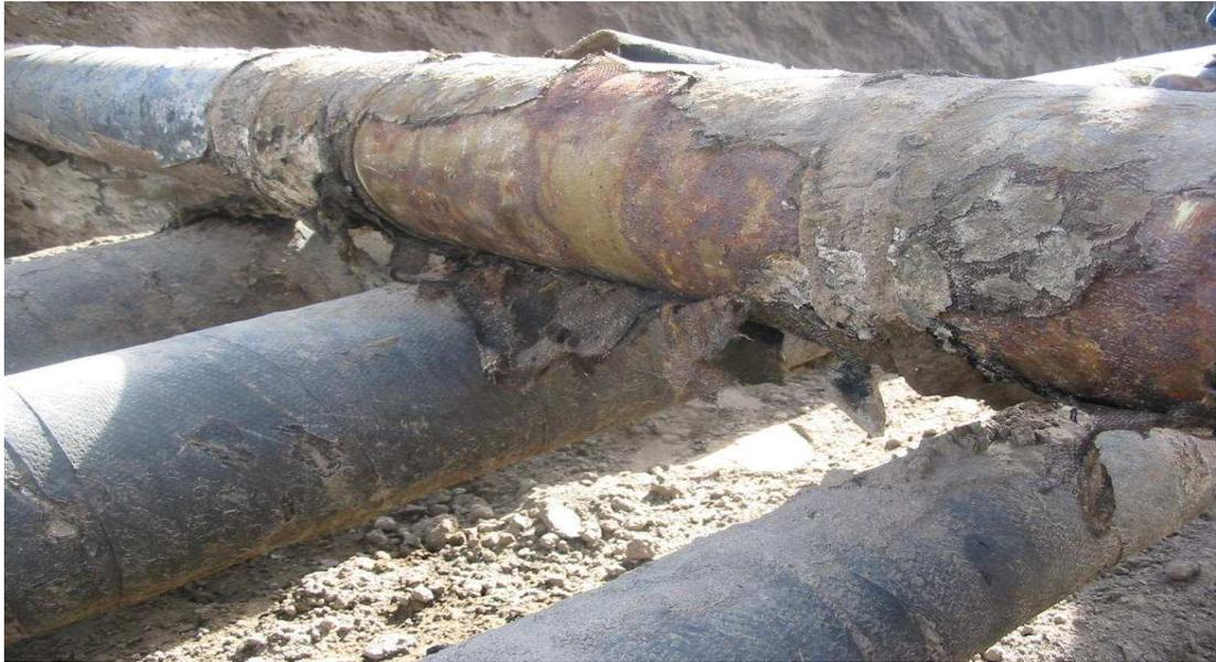
Gráfico No. 20: Revestimiento deteriorado en una tubería enterrada de Petrocomercial
