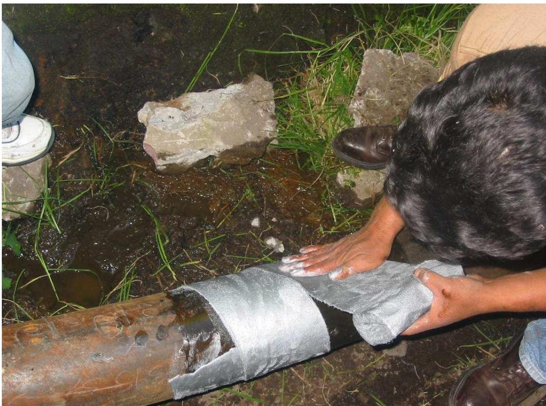
Gráfico No.19: Aplicación de revestimiento tipo cinta en tubería enterrada de Petrocomercial
