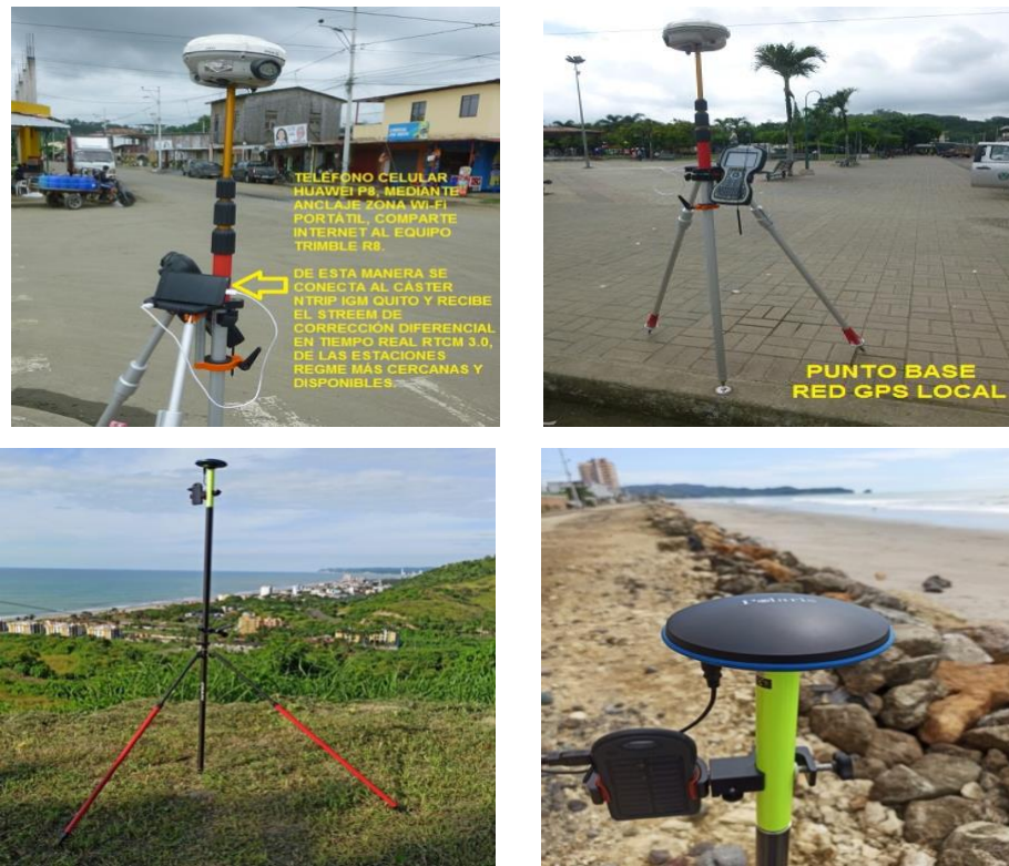
Ilustración 12. Conexión al Caster NTRIP IGM, equipos Gama Alta y Low Cost
