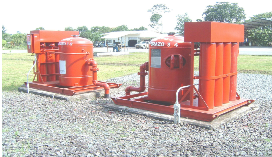
BOMBONERAS 2000 LBS PQS Y CAMARAS DE ESPUMA QUÍMICA. Fotografía No 11 Fuente Petrocomercial
