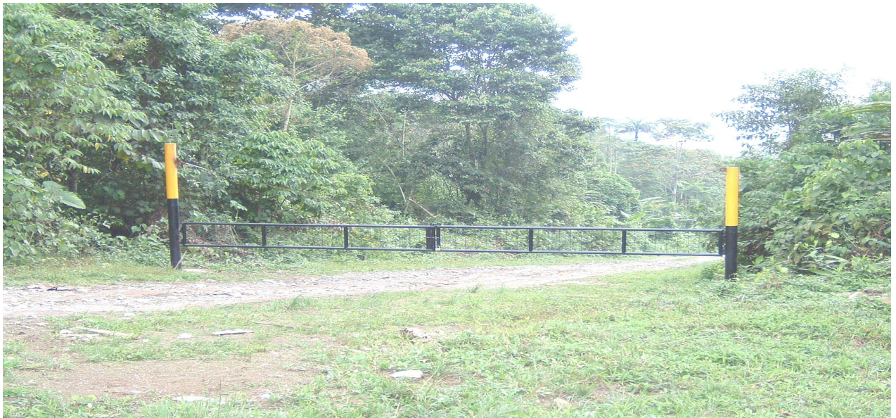
COMPUERTA DEL COSTADO SUR. Fotografía No 18 Fuente Petrocomercial
