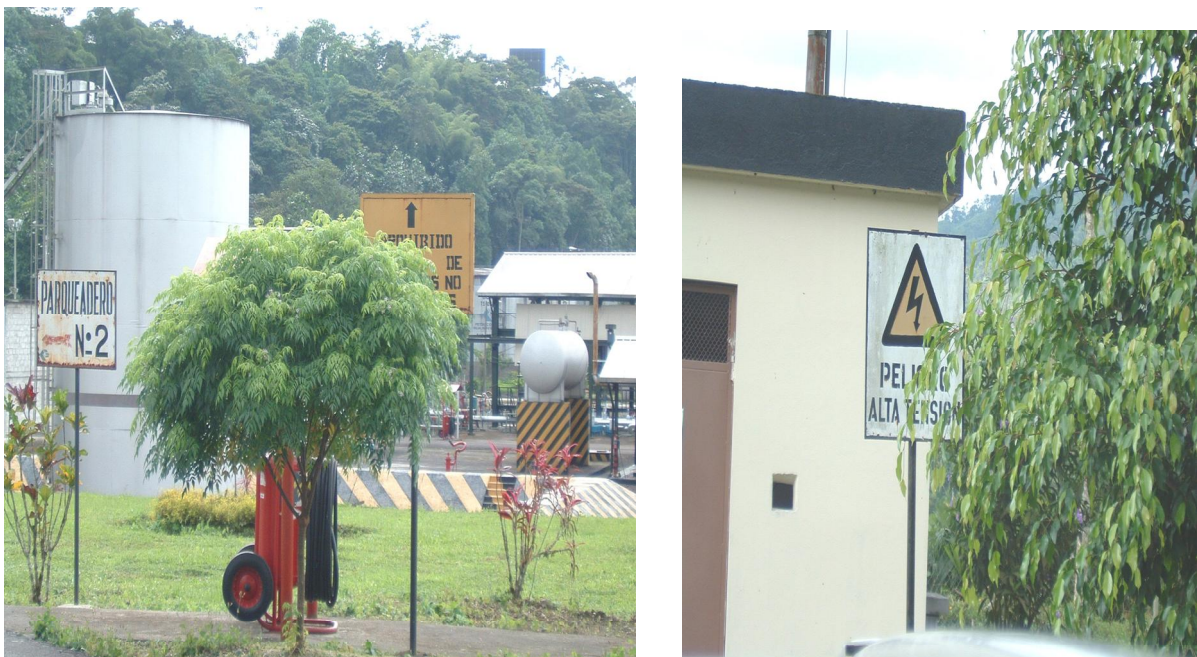
REUBICACION DE SENALES: Fotografías Nos 19 y 20. Fuente Petrocomercial
