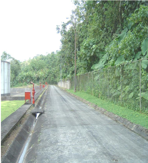
FALTA DE SEÑALÉTICA Fotografías Nos 21 y 22. Fuente Petrocomercial
