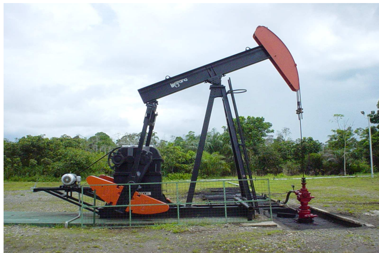
Fig-21.- Sistema de Bombeo Mecánico
