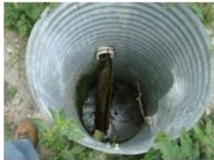
**Foto 24.** Colocación de Pozos o galerías para proceder a drenar el agua.
