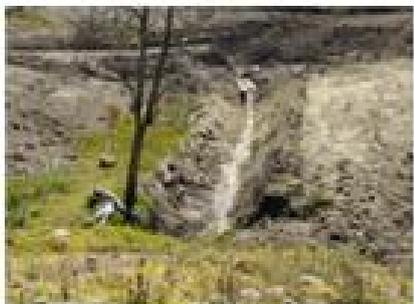
**Fotos 26.** Construcción de subdrenes que evacuan el agua en el caso del ejemplo fotográfico en la quebrada de la zona.
