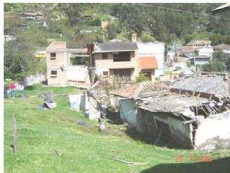
**Fotografía 5.** Vivienda destruida en el deslizamiento reactivado
