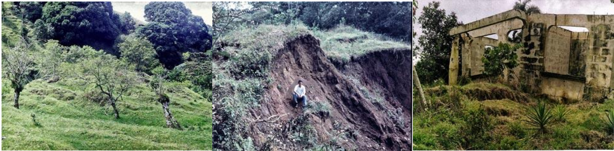
Foto 4. Árboles inclinados Foto 5. Bloques inclinados contra el sentido de la ladera Foto 6. Pisos agrietados, paredes inclinadas
