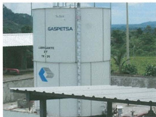
REGLETA DE MEDICIÓN EXTERNA
