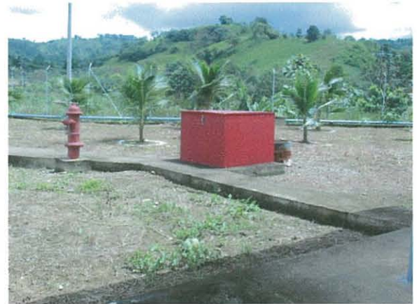
CASA DE MANGUERAS
