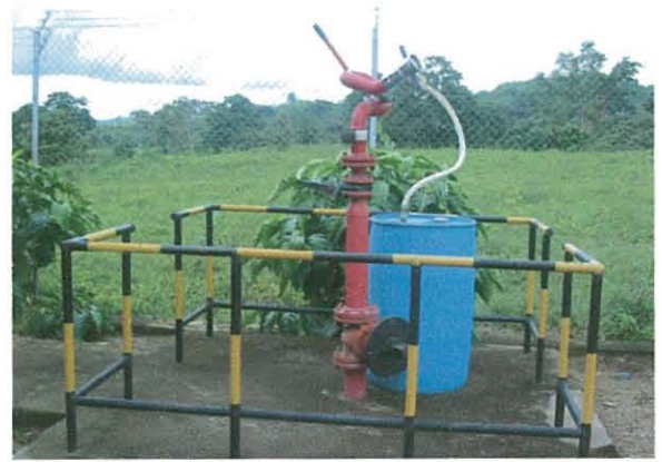
MONITOR ESPUMA-AGUA
