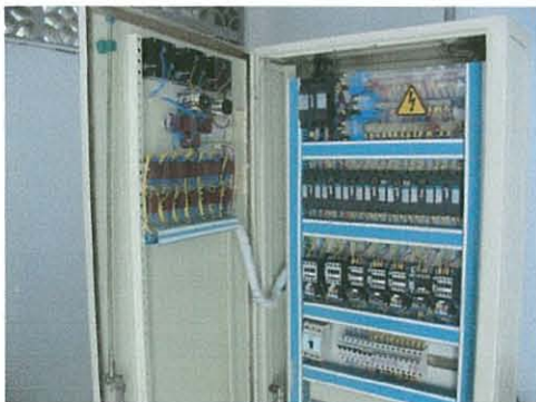
CONTROLADOR DEL CCM
