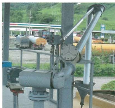
REGLETA DE MEDICIÓN EXTERNA
