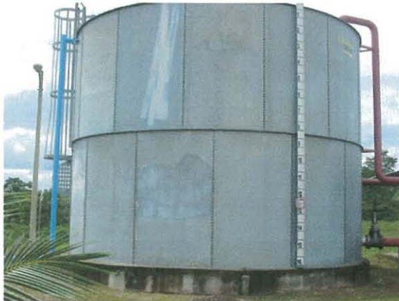
TANQUE GALVANIZADO PARA AGUA CONTRA INCENDIOS
