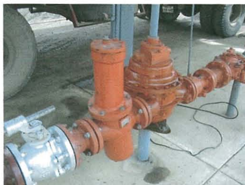
VÁLVULA DE CORTE Y FILTRO
