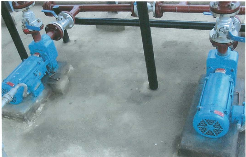
SE INSTALARON BOMBAS DE 2HP, 5HP, 10HP
