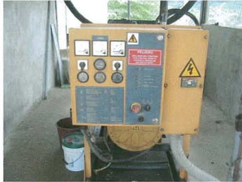
GENERADOR CON MOTOR DIESEL DE 50 KVA
