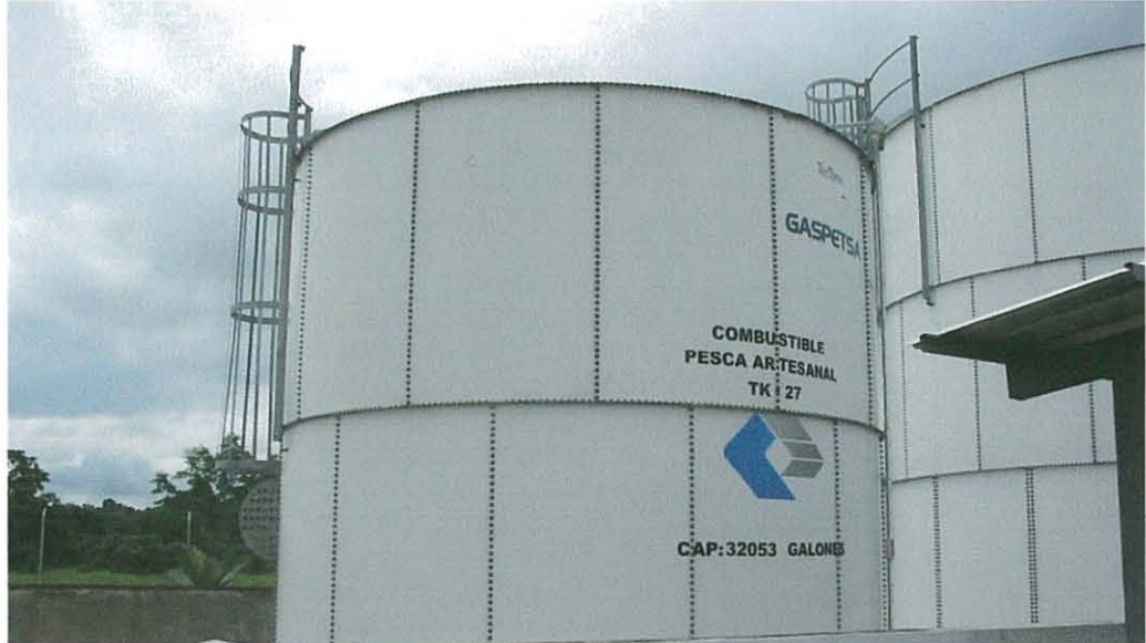
TRES TANQUES TIPO PERNADOS
