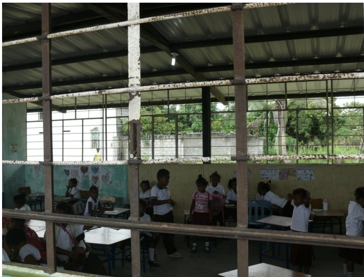
FOTOGRAFIA N° 7 INFRAESTRUCTURA Y FUNCIONAVILIDAD DEL LUGAR
