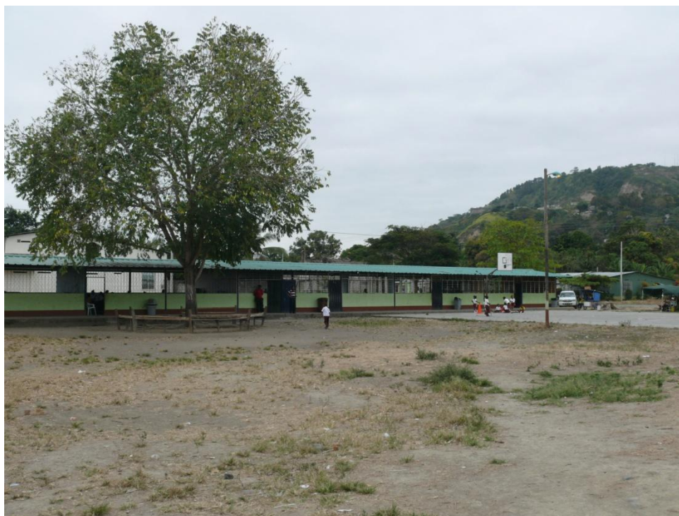
FOTOGRAFIA N° 2 AREA DE INGRESO
