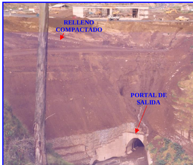
FIGURA N. 5.3 VISTA DEL PORTAL DE SALIDA DEL TUNEL Y RELLENO DEL CAUCE PRINCIPAL DEL RÍO (FUENTE EMAAP-Q año 1985)
