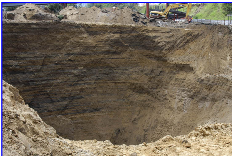
FIGURA N. 2.4 VISTA DEL TRAMO DEL EMBAULAMIENTO COLAPSADO
