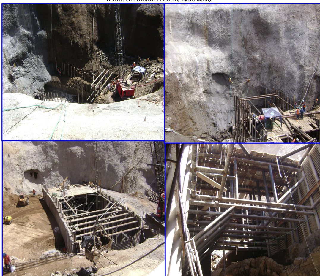
FIGURA N. 9.2 RECONSTRUCCIÓN DEL TRAMO COLAPSADO DEL COLECTOR
