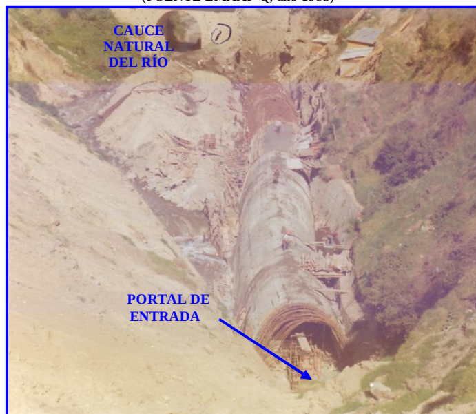
FIGURA N. 5.4 EMBAULAMIENTO DEL RÍO MACHÁNGARA (FUENTE EMAAP-Q, año 1985)
