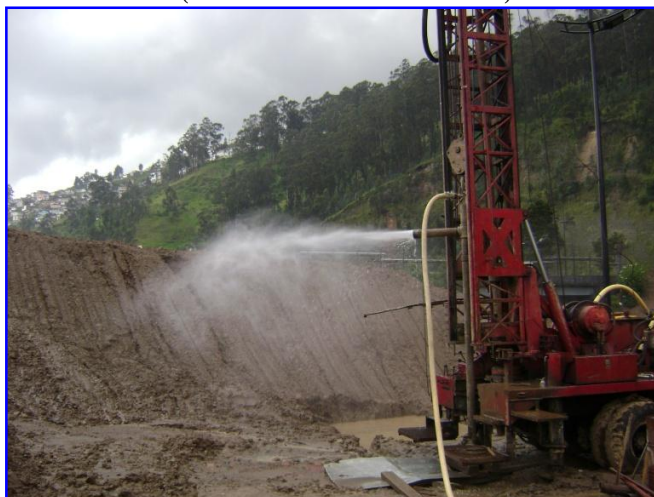
FIGURA N.8.5 PERFORACIÓN Y DESARROLLO DEL POZO N. 2
