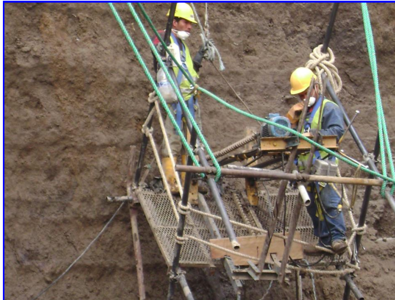
FIGURA N. 8.7 COLOCACIÓN DE DRENES
