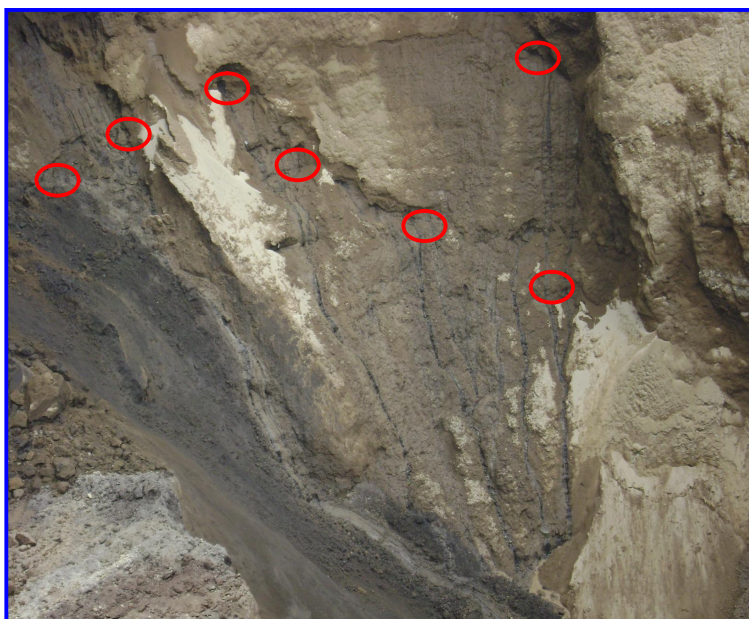
FIGURA N.- 4.2 AFLORAMIENTOS DE AGUA TALUD SUR Y SUROCCIDENTAL
