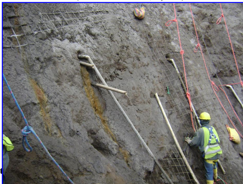
FIGURA N. 8.7 COLOCACIÓN DE DRENES
