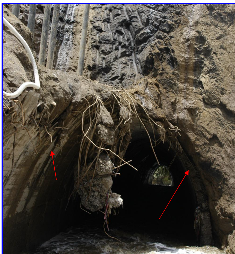
FIGURA 8.3 VISTA DE FISURAS Y FILTRACIONES EN ESTRUCTURAS
