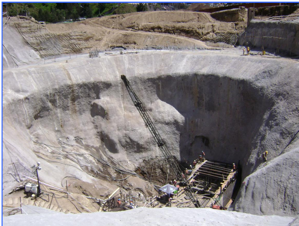
FIGURA 8.11 VISTA DE TALUDES LUEGO DE CONCLUIDO EL HORMIGONADO
