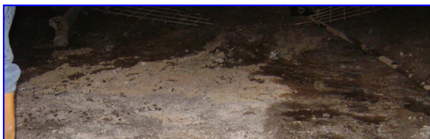
FIGURA N.- 8.12 VISTA DE UN A MUESTRA DE LA SOLERA, CONSTRUIDA CON HORMIGÓN CICLÓPEO (FUENTE NELSON ARIAS, mayo 2008)
