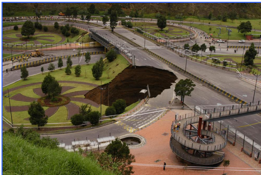
FIGURA N. 2.2 FASE INICIAL DEL HUNDIMIENTO EL TREBOL
