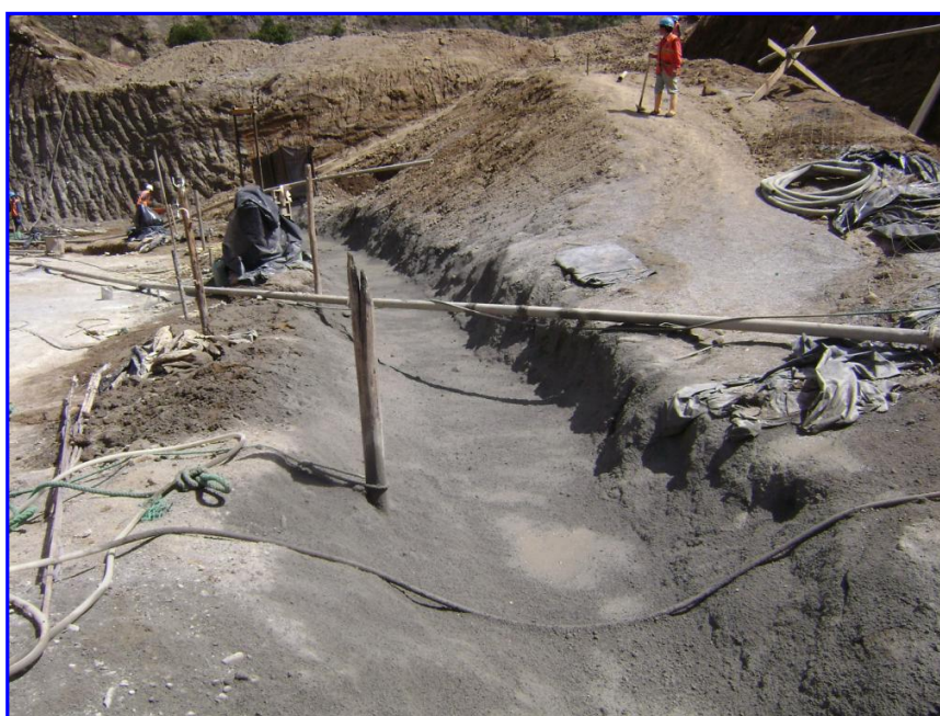
FIGURA N. 8.8 CONSTRUCCIÓN DE ZANJAS PERIMETRALES
