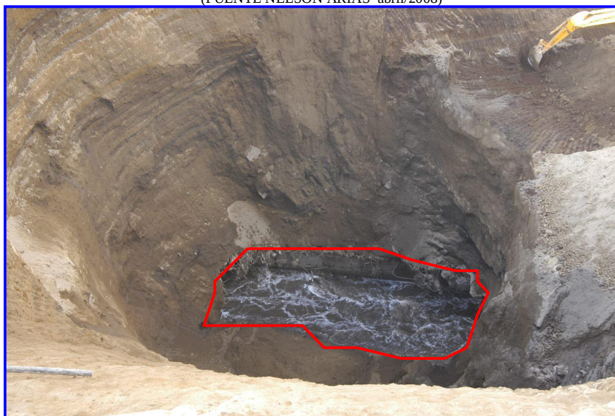
FIGURA N. 2.4 VISTA DEL TRAMO DEL EMBAULAMIENTO COLAPSADO
