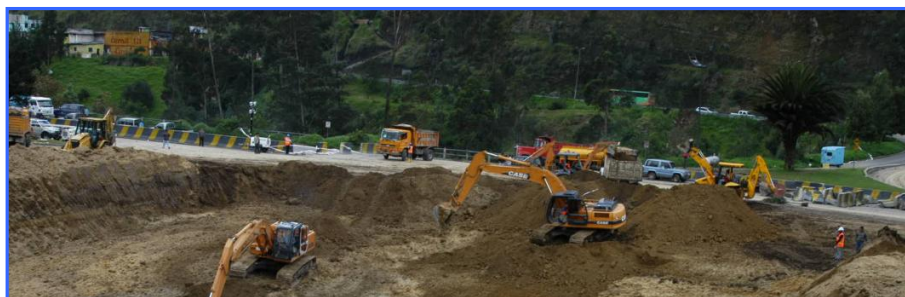
FIGURA N. 8.9 ALIVIANAMIENTO Y TENDIDO DE TALUDES
