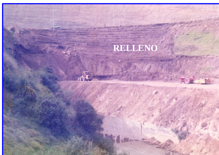
FIGURA N. 5.6 PROCESO DE RELLENO SOBRE EL EMBAULADO DEL RÍO
