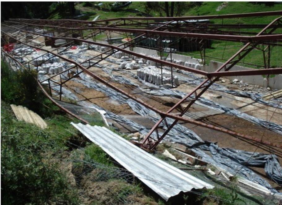
**Ilustración 13: daños en la estructura de planta avícola**
