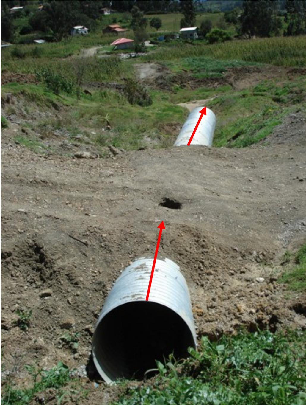
**Ilustración 11: destrucción de tuberías**
