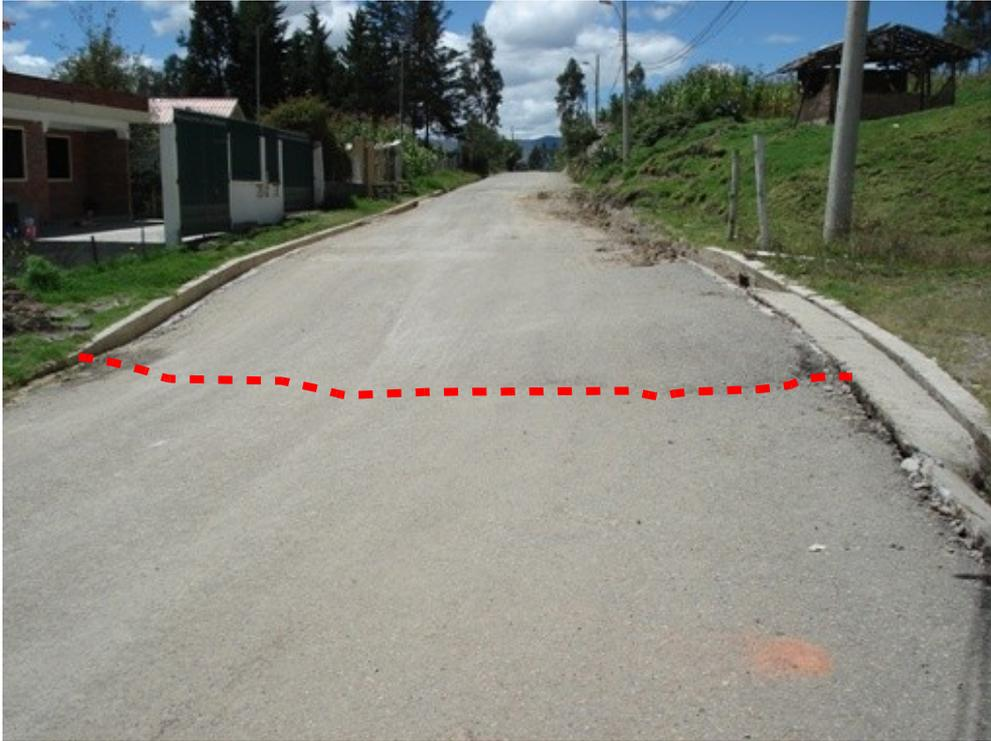
**Ilustración 10: hundimiento en acceso principal**
